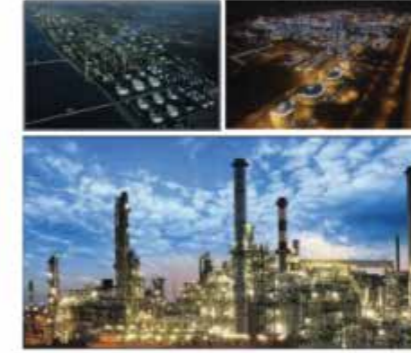
Tên dự án: Nhà máy lọc dầu Nghi Sơn Refinery
