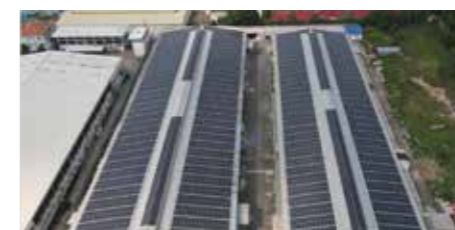
Tên dự án: All Green Vina Địa điểm: Bình Dương, Việt Nam
